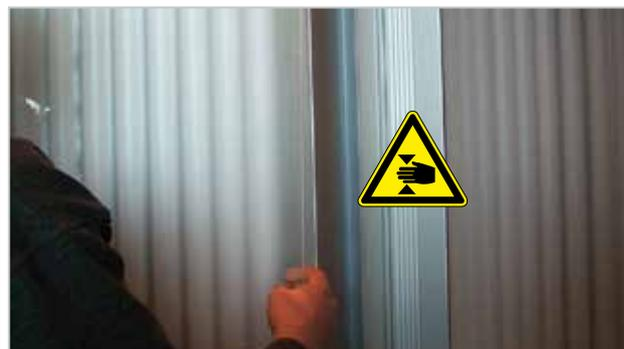
Zum Einbau die Scheibe auf der gesamten linken Seite einlegen und gegen das Aluprofil drücken.
